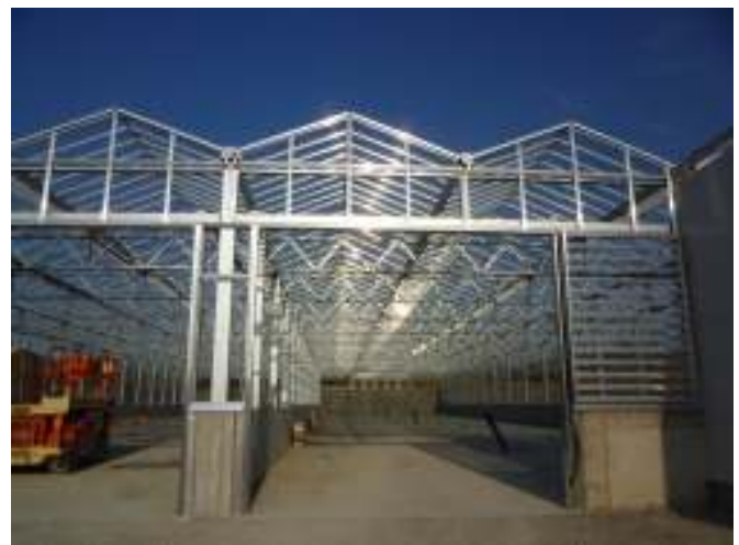
Halle für solare Klärschlamm-trocknung (Bild LRA)
