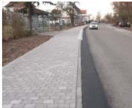
Nach dem Umbau
