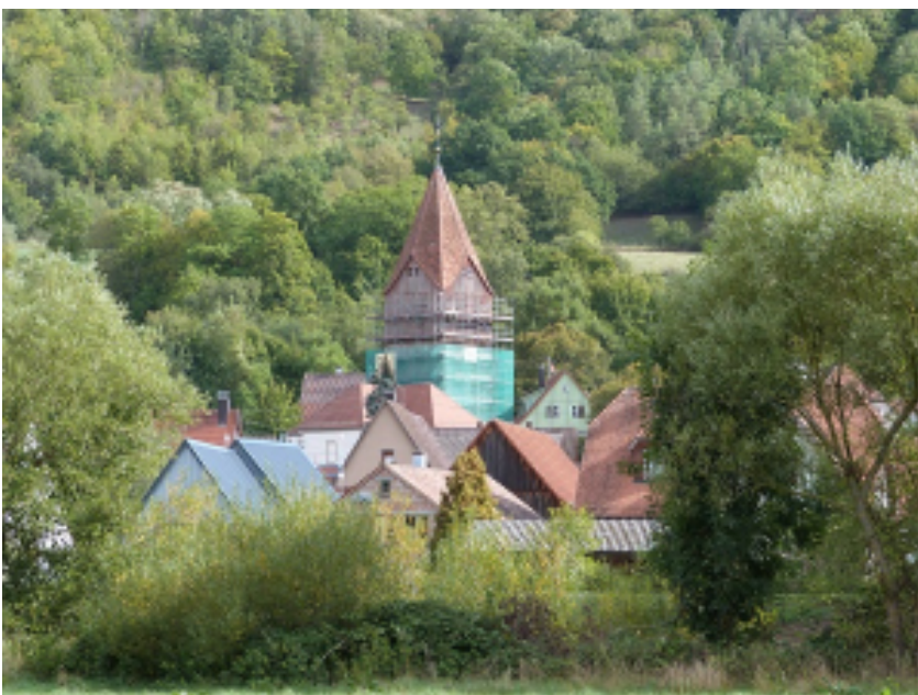
Abb. 1: Kirchturm Geislingen mit bedeutenden Fledermaus-Vorkommen während der Sanierung (Foto A. Hohmann UNB, 15.09.2015)
